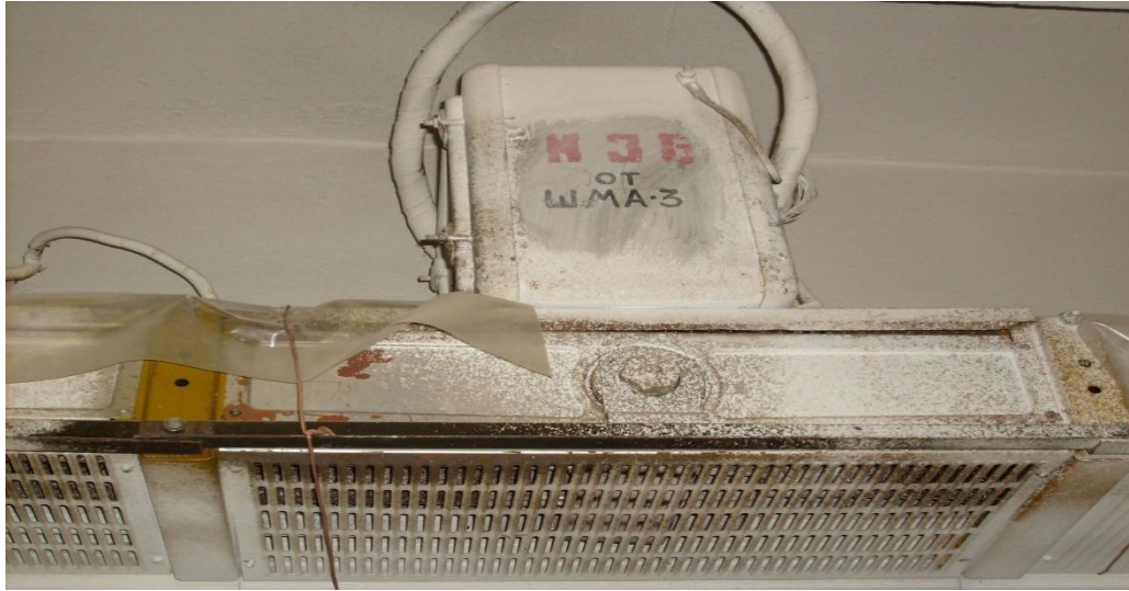
1.1-сурет - МШӨ-3 шиналық құбыры және К-36 қосу секциясы
